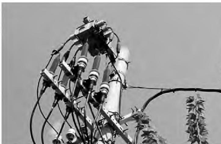
写真1 6,600V耐塩害終端接続部施工例
