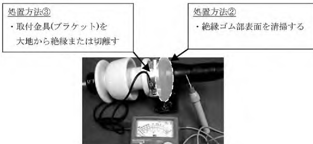
写真2 耐塩害終端接続部の処置例
